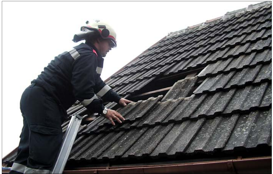
Reparatur eines Ziegeldaches in Höbenbach nach dem heftigen Sturm.
